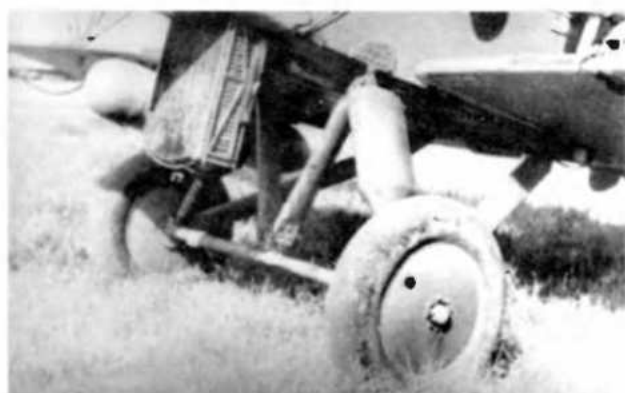
Шасси Р-5 выпуска 1934 г. Виден полностью выпу- щенный водяной радиатор
