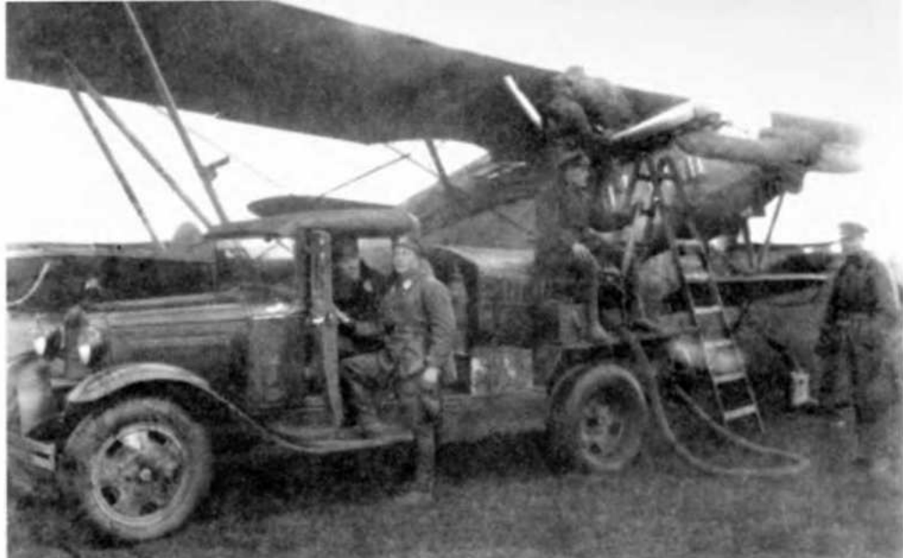
Заправка Р-5 бензином от заправщика на шасси грузовика ГАЗ-АА, 1935 г.
