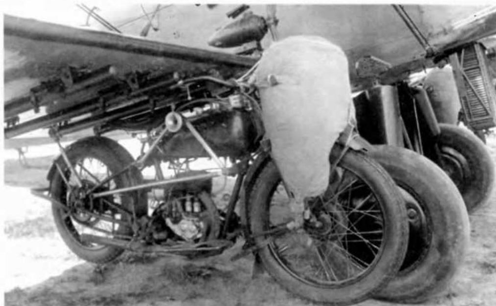
Подвеска мотоциклов в вертикальном положении, предложенная инженерами 3-й бригады особого назначения, 1936 г.
