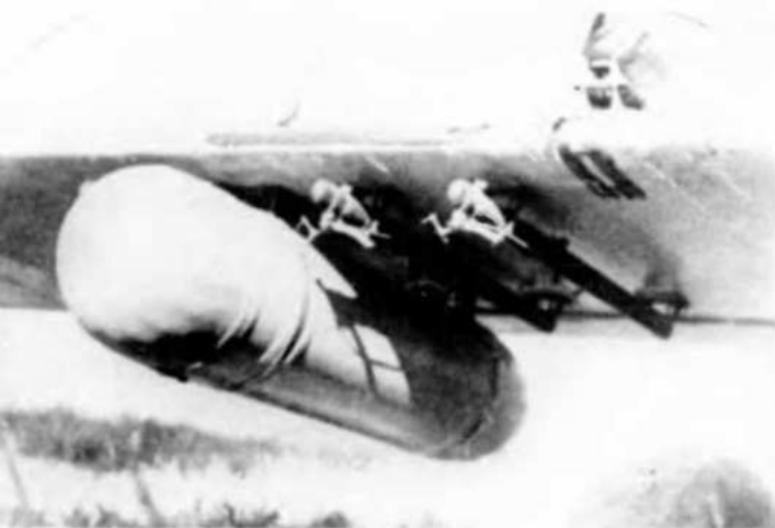
Параютный контейнер, закрепленный на бомбодержателе под крылом
