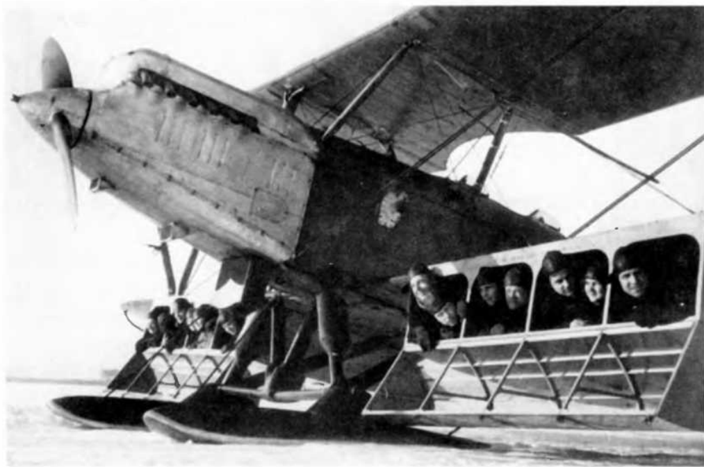
Опробование одного из первых вариантов кассет Г-61 для перевозки пассажиров и груза
