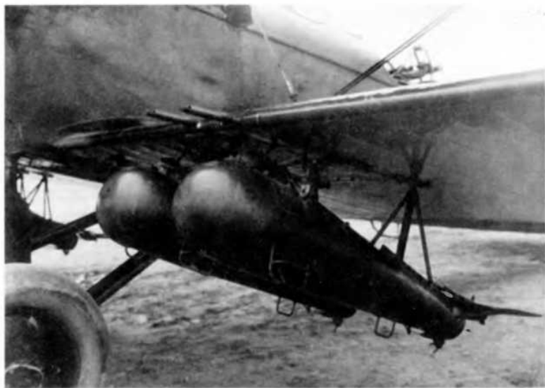
Выливные приборы ВАП-4м, подвешенные под штурмовик СССР
