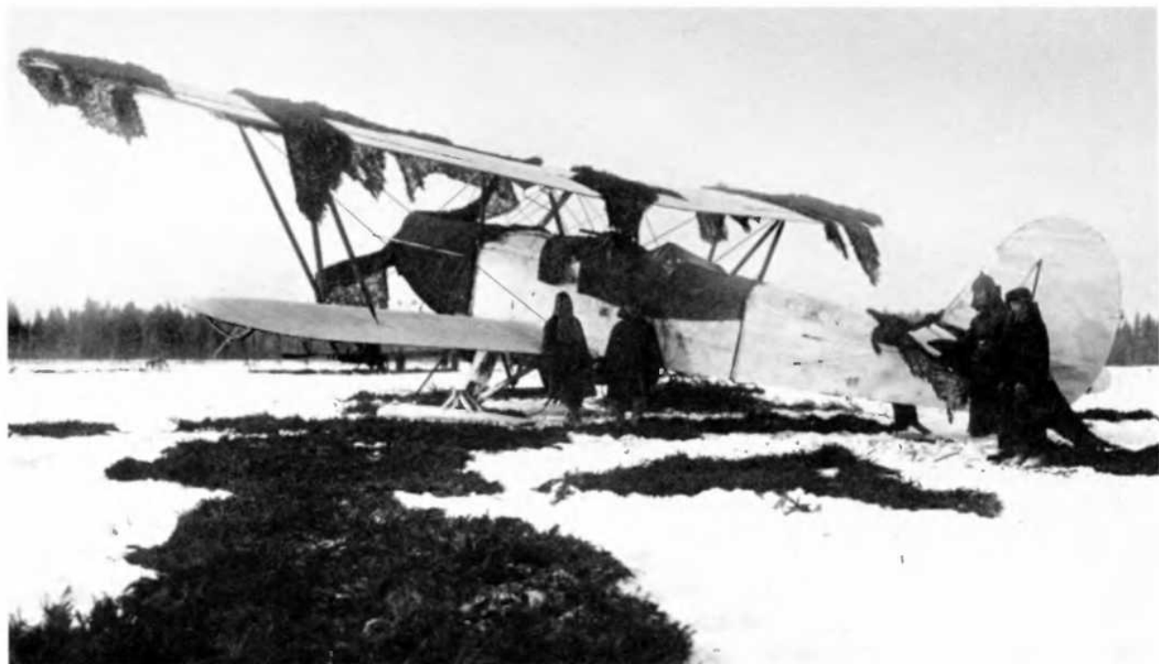
На учениях под Ногинском, февраль 1936 г. Самолет покрыт временной смывающейся белой краской, куски маскировочной сети ПС-5 имитируют прогалины на снегу
